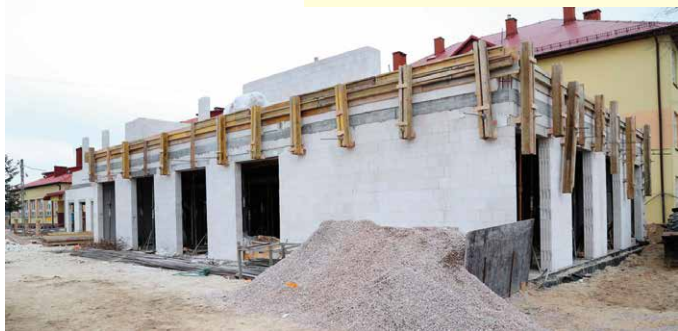
Prace przy budowie żłobka idą pełną parą.
