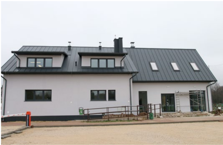
> Budowa zaplecza KS Moravia
