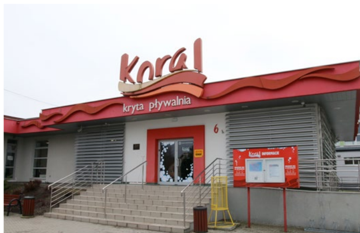
> Termomodernizacja i przebudowa krytej pływalni Koral Morawica
