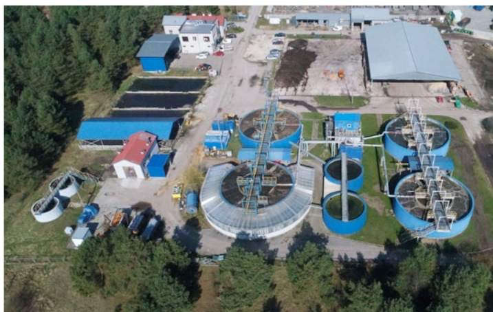
> Rozbudowa i przebudowa oczyszczalni ścieków Brzeziny
