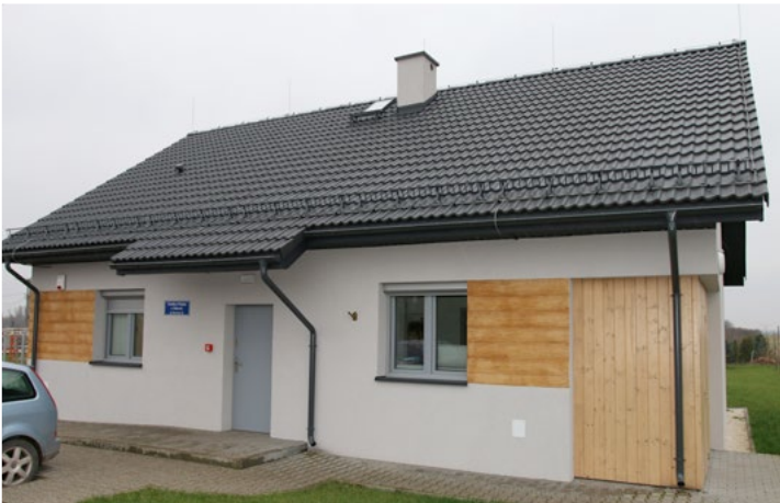
> Budowa świetlicy wiejskiej Zaborze
