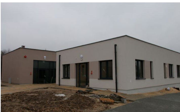
> Budowa Centrum opiekuńczo-mieszkalnego w Brudzowie
