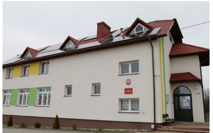
> Termomodernizacja Szkoły w Chmielowicach
