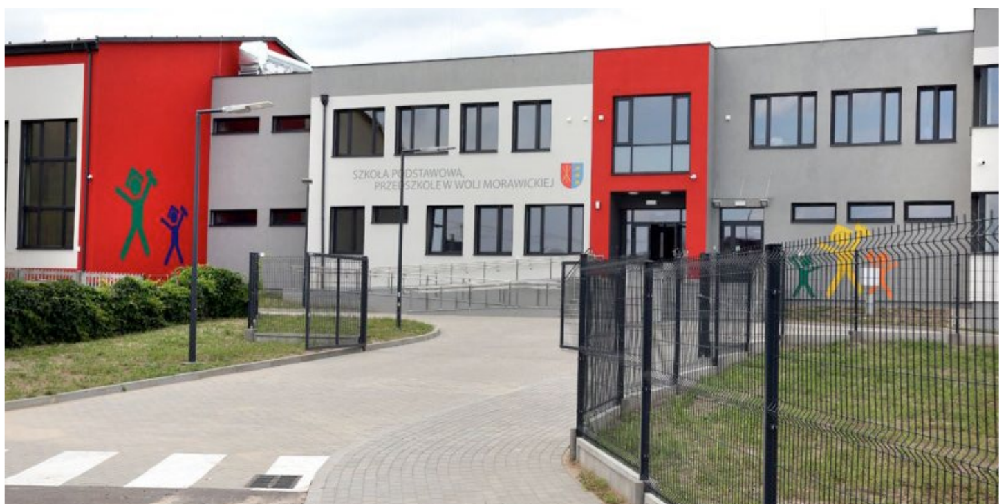
> Budowa Szkoły Podstawowej w Woli Morawickiej
