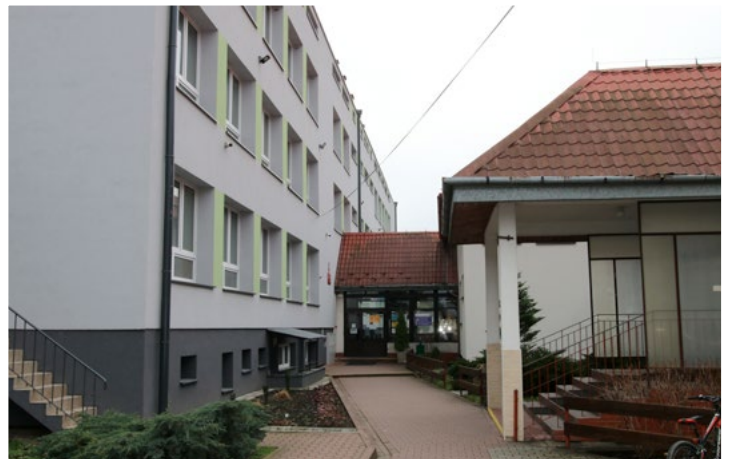
> Termomodernizacja ZPO w Morawicy
