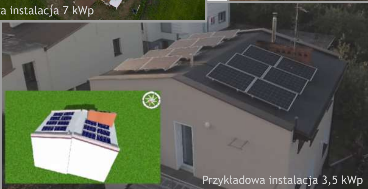
Przykładowa instalacja 4,75 kWp
